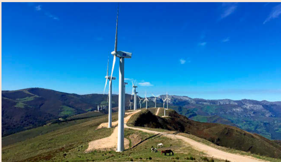
Parque eólico de Cañoneras (Cantabria).
